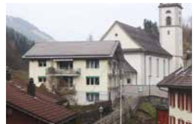
Das Pfarrhaus vor der Kirche Flühli mit dem Fotovoltaikdach.
